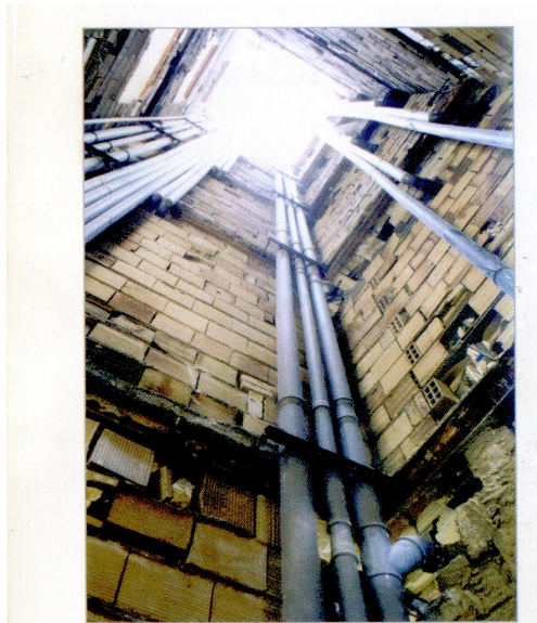
شکل ۶ نحوه استقرار منظم لوله‌های قائم فاضلاب و هواکش در یک طرح
