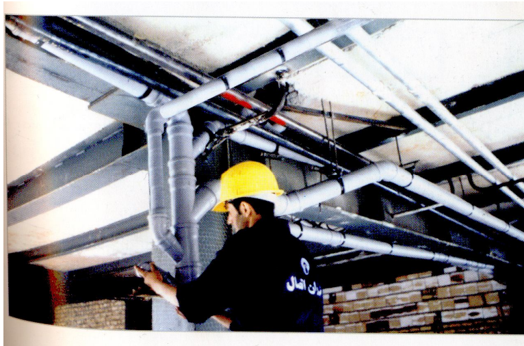
شکل ۴ چگونگی قرار گرفتن لوله‌های جانبی فاضلاب و اتصال آنها به لوله قائم
